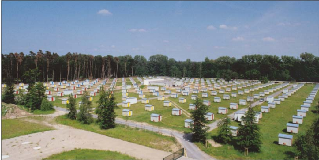
200 x 200 m 2 , 256 Detektoren, Abstand 13 m, 10 14 eV...10 17 eV
